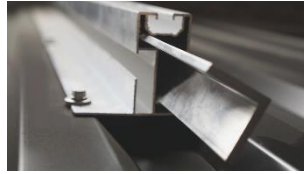
B. För in profilförbindare i skena.
