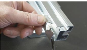
A. Montera kabelclips för hand, i skåra på skena.
