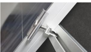
D. Skjut intill mittklämma mot solcellspanel.
