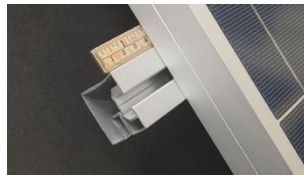
B. Skena behöver sticka ut minst 40 mm.
