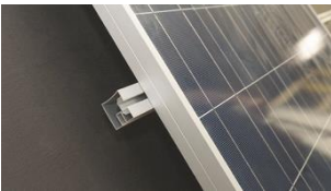
A. Placera solcellspanelen på skenor.
