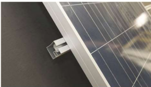
A. Placera solcellspanelen på skenor.
