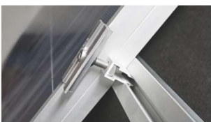
D. Skjut intill mittklämma mot solcellspanel.
