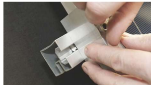
E. Gänga i ändklämma och insexskruv för hand, för att undvika korsgängning.
