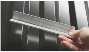
A. Tag fram profilförbindare.
