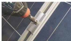
E. Skjut intill nästkommade solcellspanel och drag åt. Åtdragningsmoment 8–10 Nm
