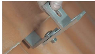
B. Placera T-vinkel under takkrok, med räfflade sidor mot varandra och justera till önskad höjd.
