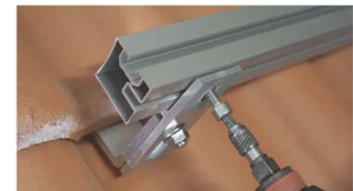
C. Drag åt skena med kort insexskruv. Åtdragningsmoment 8–10 Nm
