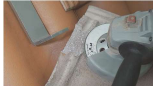
E. Fräs av klack på överliggande takpanna.
