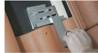
C. Tryck i takkrok för hand, du skall EJ slå eller använda våld. Se avsnitt OBSERVERA för mer info
