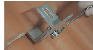
C. Drag åt med flänsmutter. Åtdragningsmoment 25–27 Nm
