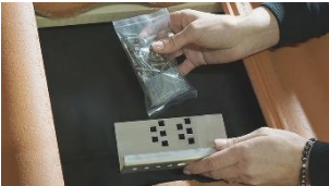
A. Avlägsna takpanna och tag fram grundfäste, samt skruvsats till takkrok.
