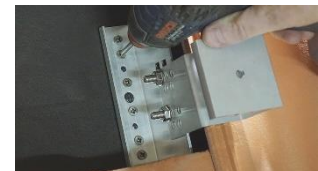
F. Skruva fast grundfäste i underlag. Använd 5–6 st träskruv
