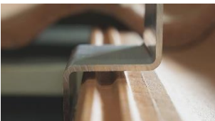
D. Sidofäste skall hänga fritt ca 2–3 mm från underliggande takpanna.
